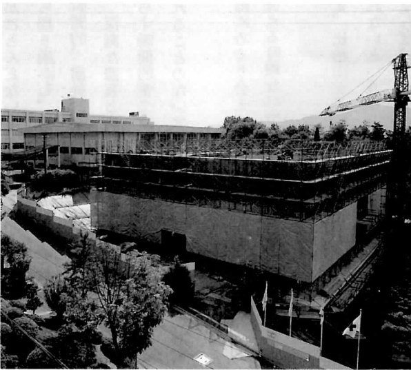
建設中の総合情報館
