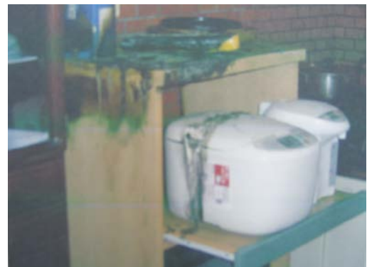
図6 炊飯器の高温蒸気接触による乾燥剤からの出火による焼損の様子
