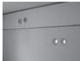
大梁と耐震壁
