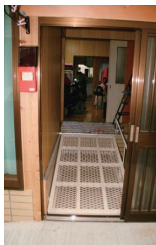
図3 特注の金属製スロープ
